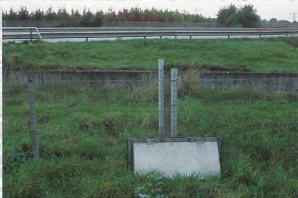
Retourpoortje in raster langs snelweg A73. Mocht de das aan de gevaarzijde van het raster geraken dan kan hij via zo'n poortje ontsnappen naar de veilige kant (foto: Rob Buser).
